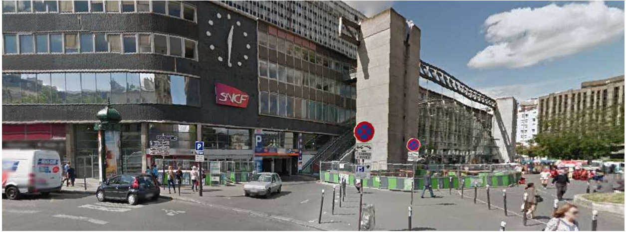
Ungefähre Lage des ehem. Hôtels Maine (2014)
