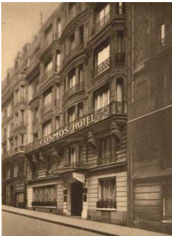
Ehem. Hôtel Cosmos, 14, rue Lentonnet, 75009 Paris (1934)
